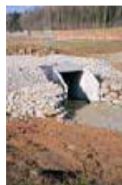
dalot en béton
